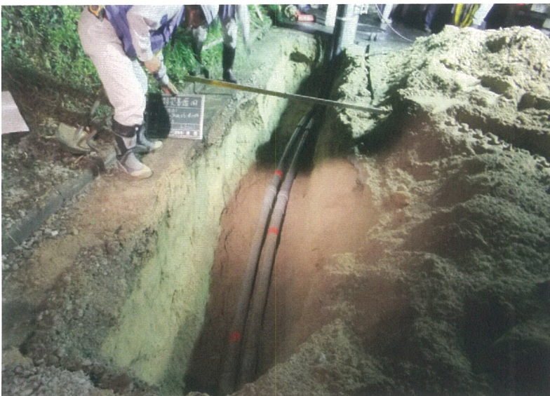
◆浜田～江津間 中継光ケーブル40芯張替え 仮復旧 模様
