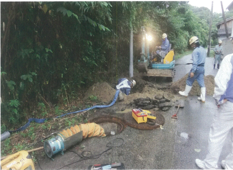
◆被災現場での復旧作業 模様
